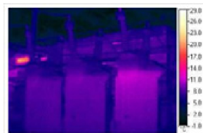
Нагрев бака масляного выключателя 110 кВ (снимок сделан тепловизором ТН-7102)
