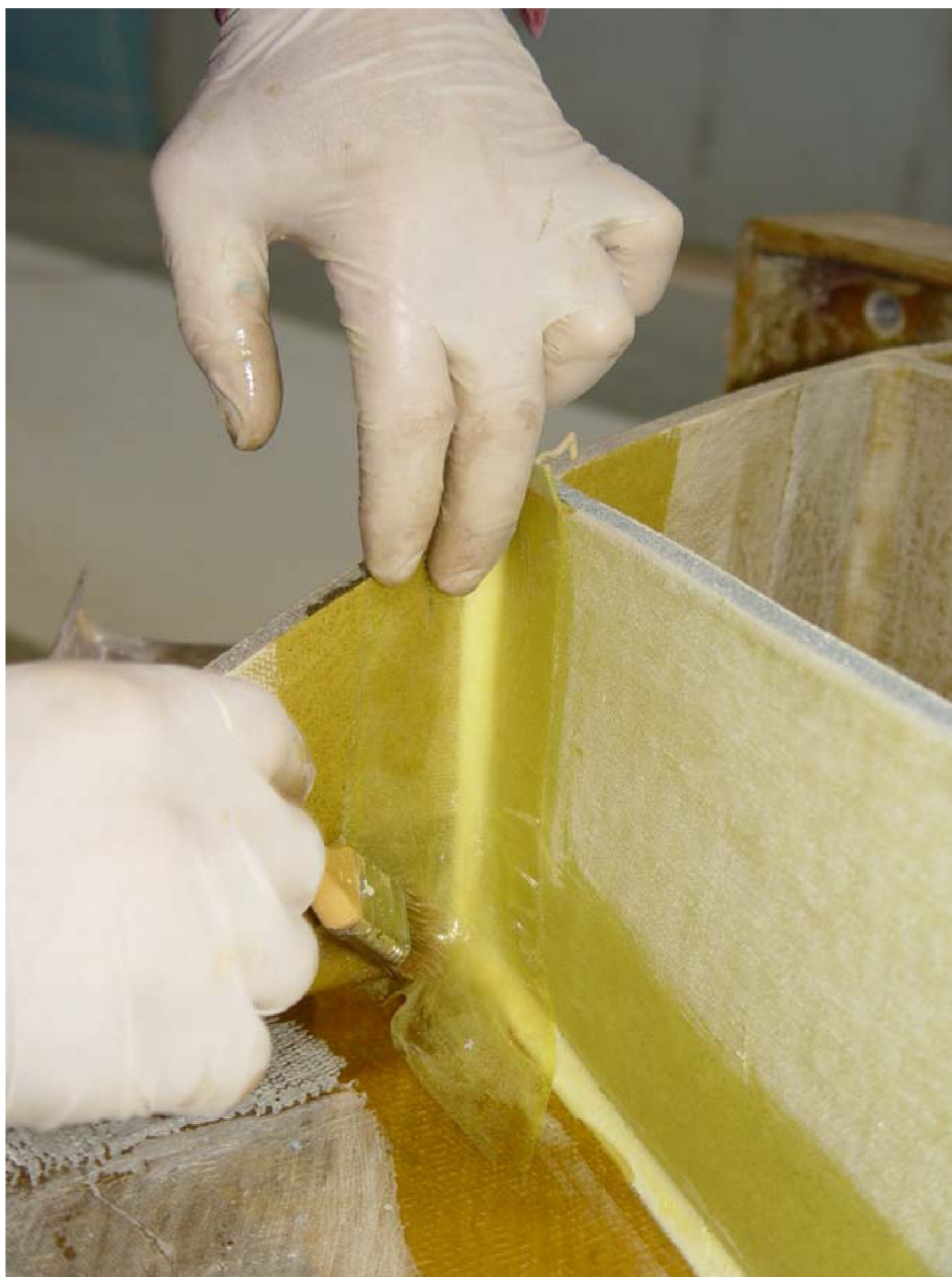
Рисунок 33 – проклеивание места стыка мокрым уголком.
