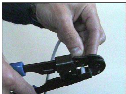
1. Зачистка наружной изоляции круглого кабеля витой пары
