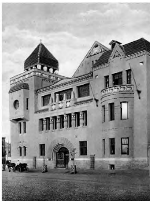
Здание Крестьянского поземельного банка. Архитектор А.И. Гоген
