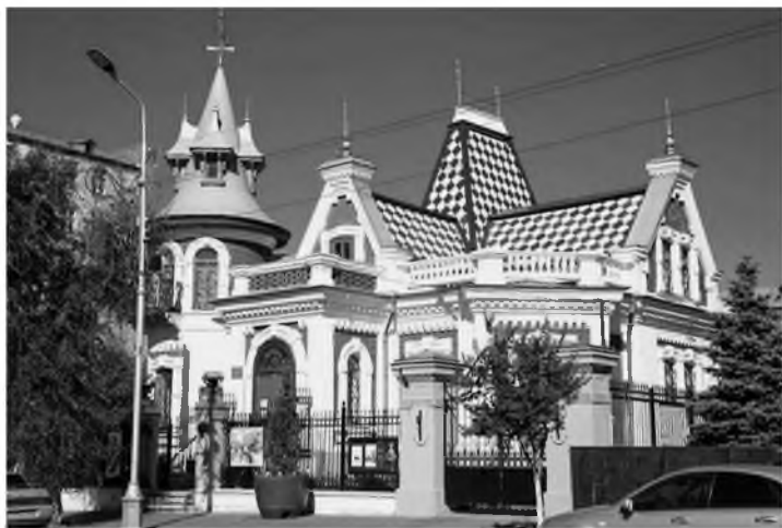
Особняк И.А. Клодта. Архитектор А.А. Щербачев
