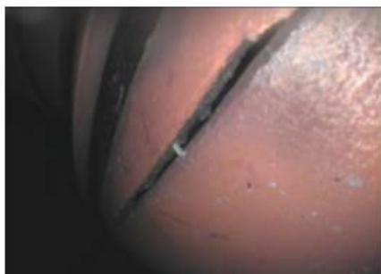
Рис.2. Вид дефектного места КС SGT-600
