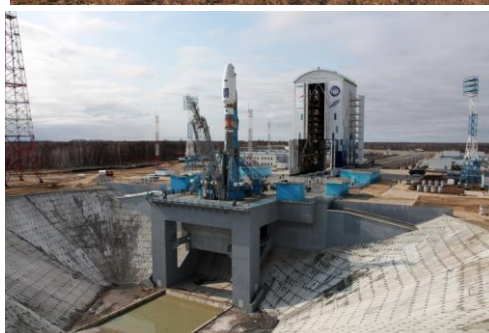
Рис. 5.8. Стартовые столы для российских ракет-носителей: а – стартовый стол под РН Протон-М, Байконур; б – стартовый стол под РН семейства Союз, Байконур; в – стартовый стол под РН семейства Союз, Восточный
