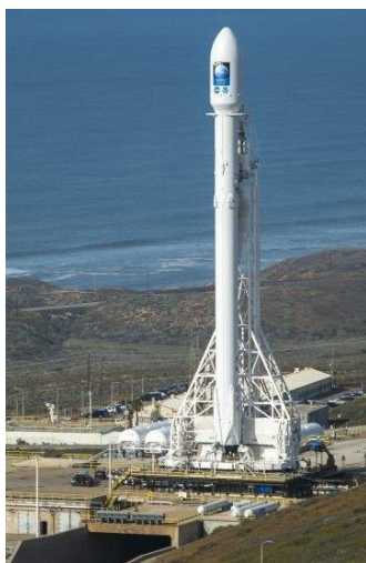
Рис. 5.6. Примеры стартовых столов для иностранных ракет-носителей: а – База Ванденберг, США, стартовый стол под РН Falcon-9; б – Куру, Французская Гвиана, стартовый стол под РН Ариан-5
