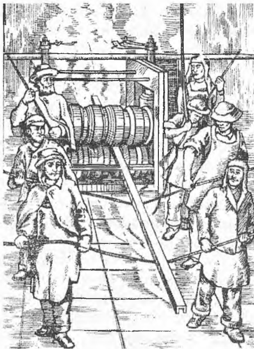
Рис. 4. Старинный сортопрокатный стан
