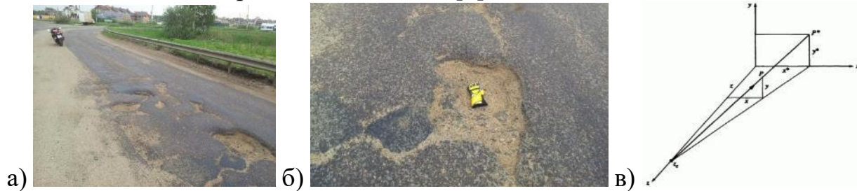
Рис. 1 Фотографии выбоин в дорожном покрытии, а) общий вид дорожной обстановки, б) перчатка водителя мотоцикла в выбоине, в) перспективная проекция точки
