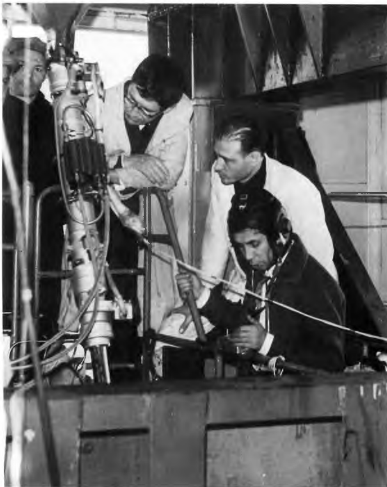
И.А. Бережной, крайний справа –В.В. Игнатьев. Подготовка к испытаниям стойки шасси знаменитой "100" (Т4).
