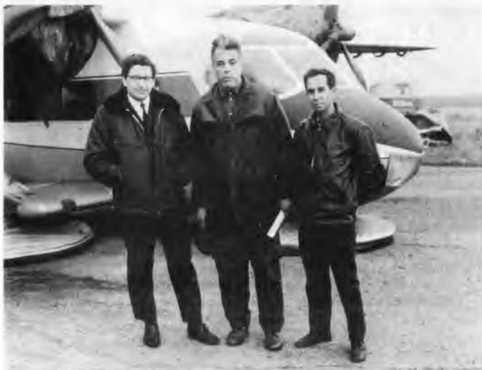
И.А. Бережной, Заслуженный летчик-испытатель СССР, ведущийлетчик-испытатель фирмы О.К. Антонова – Калинин, Главный инженер КБ шасси В.В. Игнатъев после испытаний самолета АН – 714 «Пчелка». Вместо колесного шасси – опоры на воздушной подушке.
