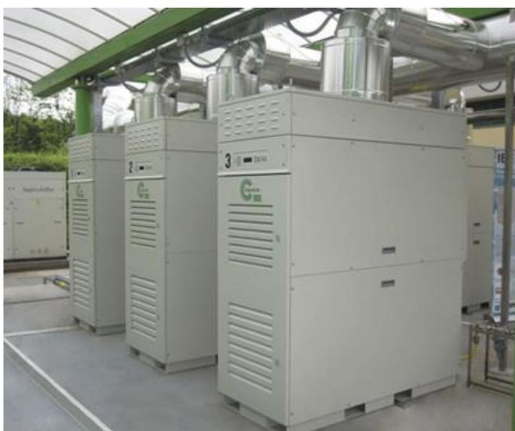
Рис. 1 – Газотурбинная установка CAPSTONE
